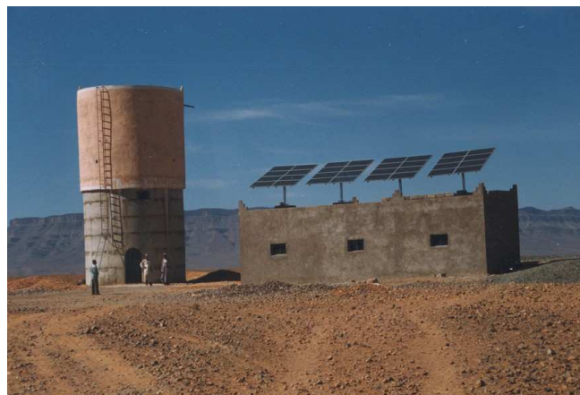
(b) Sistema de bombeo con depósito elevado.
